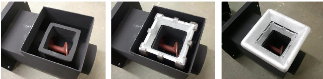
Obr. č. 12 instalace límce na litinovou hlavu
