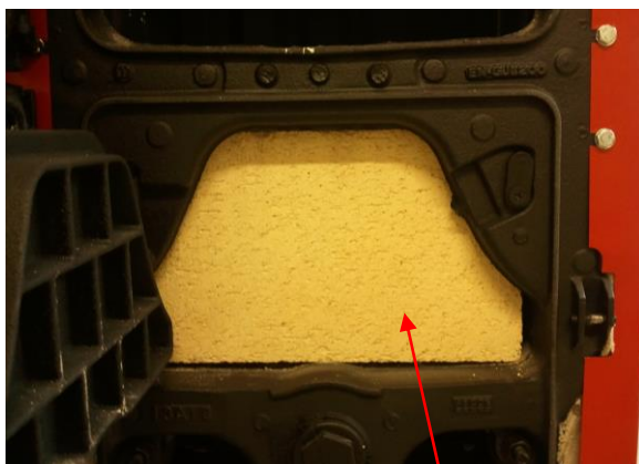
Obr. č. 9 Instalace šamotů
